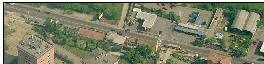
Foto 20 – Intersezione “D” / “E” – Via Gallarate / Via Capo Rizzuto / Via Torrazza
