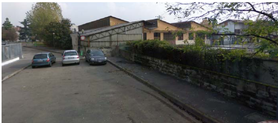
Strada fondo chiuso in Via De Chirico, a confine Nord dell'area di PII
