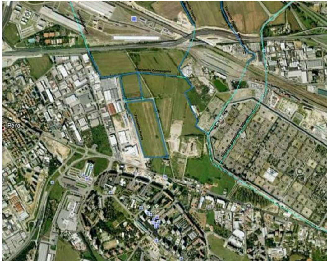
Figura 5.4-13: sistema idrico superficiale
