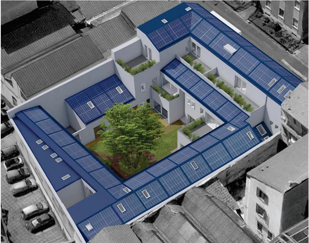
Le parti di copertura piane saranno trattate con lamiera verniciata dello stesso colore del fotovoltaico.
