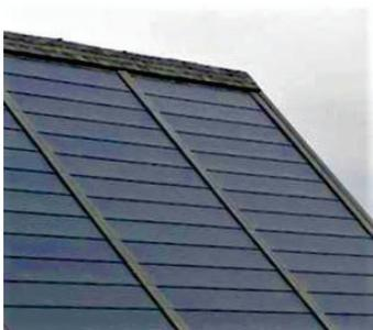
Esempio di fotovoltaico a film sottile
